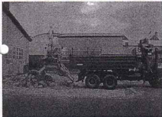
Aushubarbeiten vor der Autowerkstätte
