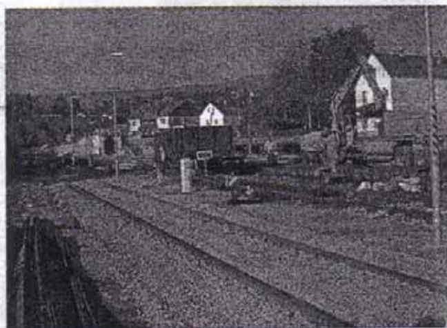
Oberbauarbeiten im Bahnhof Köflach
