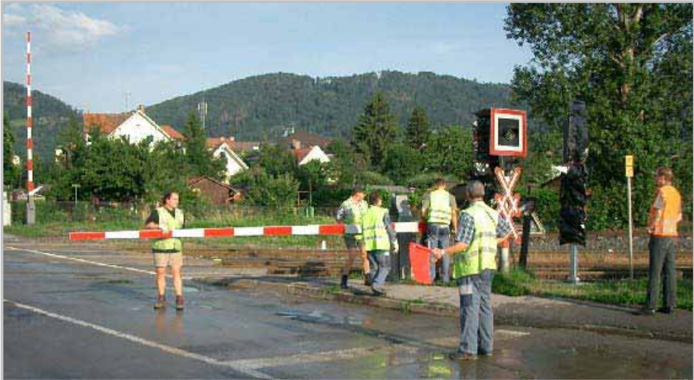
Foto oben: 13. Juli 2005, 7.31 Uhr: Die Abtragungsarbeiten an der Altanlage der EK in km 1,216 (Reininghausstraße) sind voll angelaufen.
