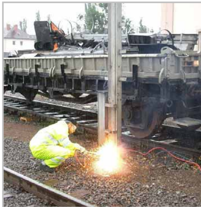
Foto oben: 12. Juli 2005, 12.39 Uhr: Die Abtragungsarbeiten an den Altanlagen schreiten zügig voran. Michael Geimer trotz dem heftigen Regen und bringt ein Signal nach dem anderen zu Fall.
